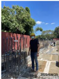
基礎柱鋼筋排架間距檢查
