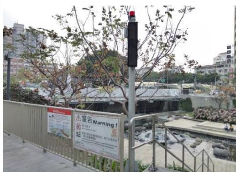
於柳川景觀河段出入口安裝 LED 跑馬字幕機、語音喇叭及閃爍警示燈，汛期河道水位達警戒值系統主動示警，提醒民眾立即離開警戒區域，以達保障市民生命財產目的。
