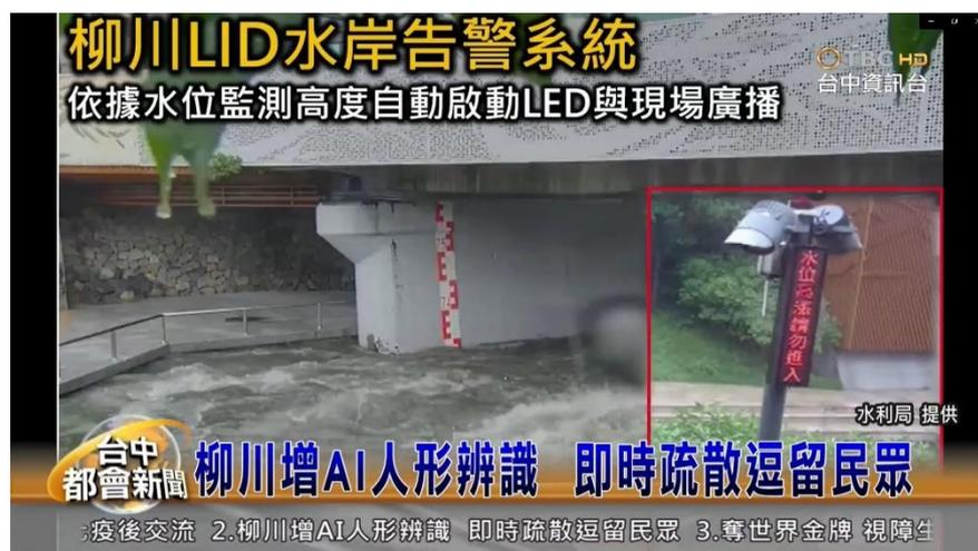
透過方框鎖定民眾，導入 AI 智慧人形辨識系統，即時掌握民眾狀況，同時連動路口 LED 警示系統，提醒民眾。
