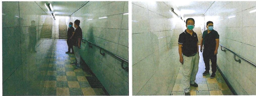
7、8) 檢查沙鹿區沙鹿陸橋人行地下道。
