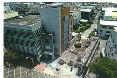
現場目前施工拆除中照片
