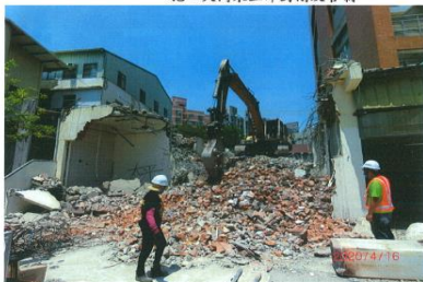
施工人員未穿著反光背心。
