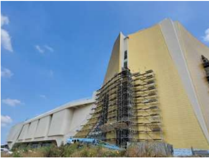
3D 造型金屬板施作
