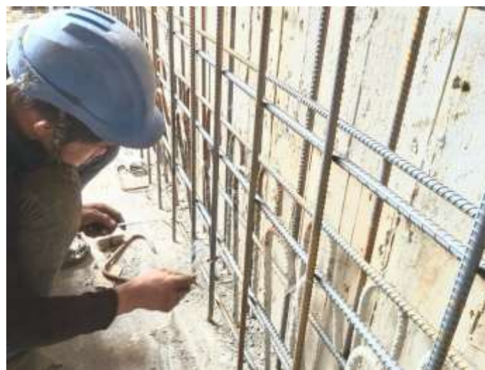
鋼網牆骨架施作
