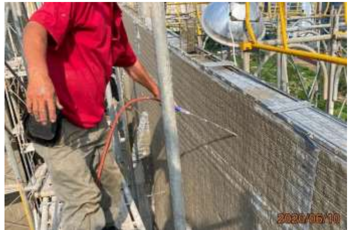
R1F 鋼網牆澆置作業
