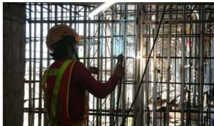
鋼網牆骨架施作
