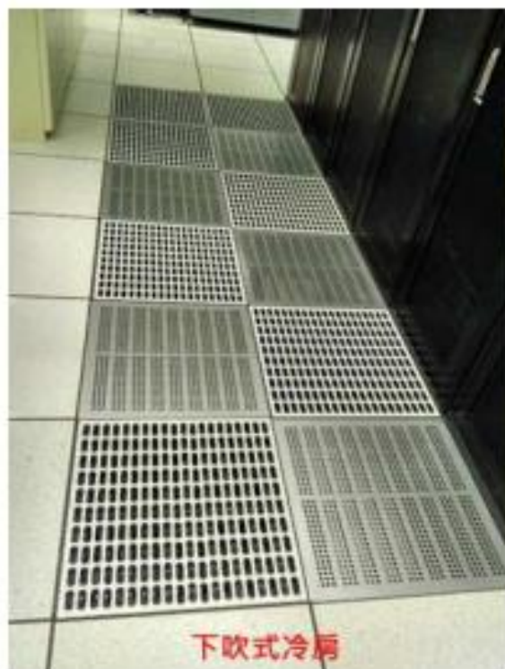
機房為下吹式冷房，各機櫃熱通道可封閉設計
