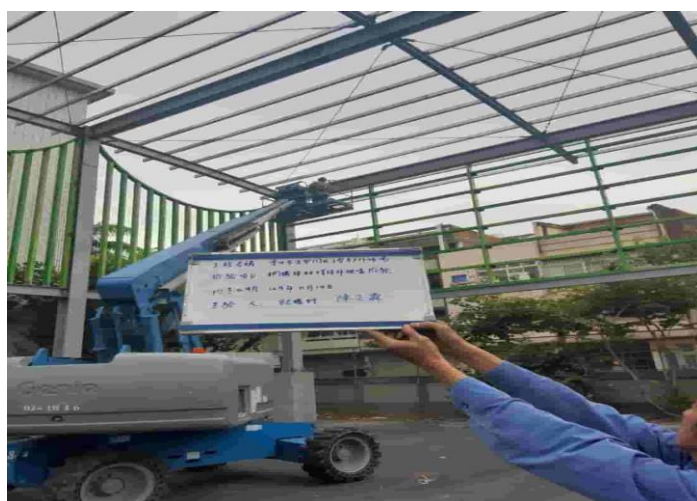
鋼構樑柱焊非破壞檢測
