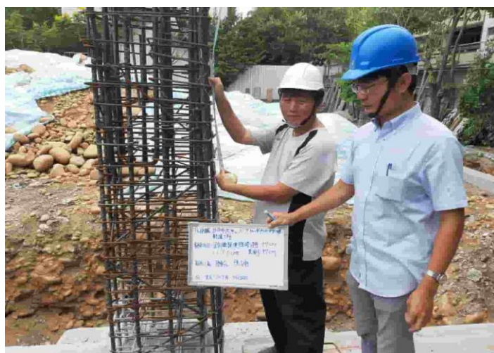
鋼構預埋螺栓檢測
