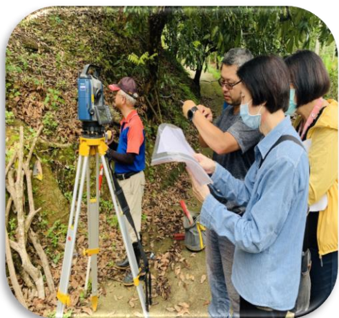
協助指界作業，現場放樣釘樁。
