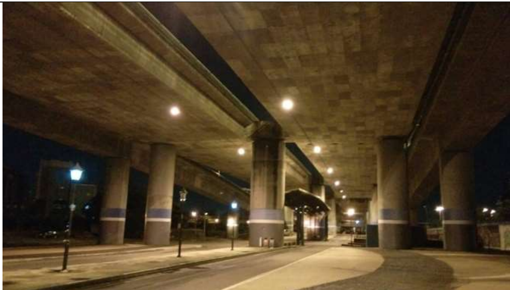
74 號快速道路橋下湖日休閒廣場
