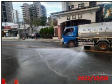
工區外加強水車清洗
