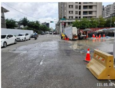
說明：基地開挖期間，每日收工後，立即派遣水車清理道路
