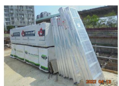
說明：工區內物料堆疊，統一堆放整齊
