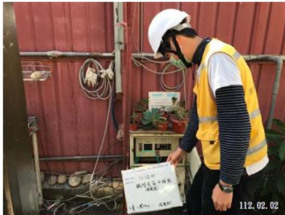
說明：開關箱設置中隔板查驗
