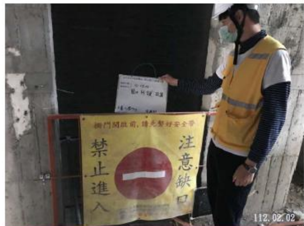
說明：開孔防護設置查驗
