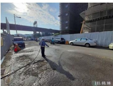
說明：每日收工後，立即派遣水車清理道路
