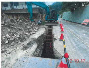
施工護欄抽查
