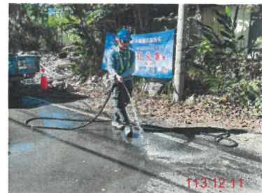
工區灑水檢查
