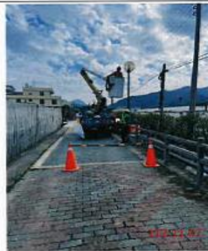
照片 3(施工場域前後皆有放置交通錐及連桿，尚符職安規範)
