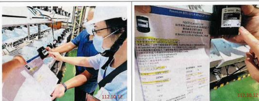
照片 1【廠驗 NEMA 控制器規格(PowerLink BTN-601)、數量(60 只)尚符契約規範】
