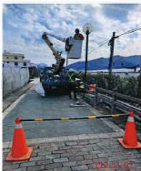
照片 1(新社白冷圳工區燈桿轉接桿與燈具安裝前作業情形)
