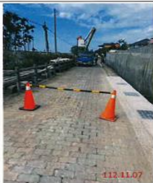
照片 3(施工場域前後皆有放置交通錐及連桿，尚符職安規範)
