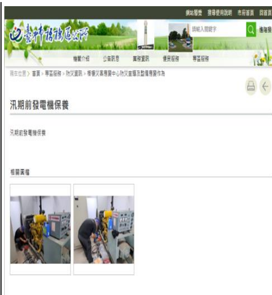
汛期前發電機保養
