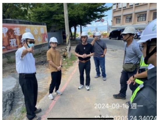
施工現場實地督導
