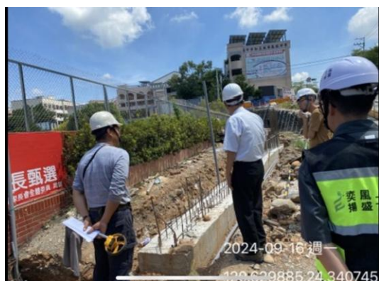
施工現場實地督導
