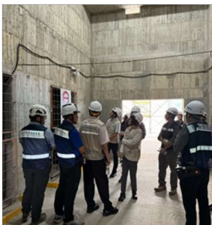
電梯井安全管制-運用AI智能技術 (2)_0_0_0
