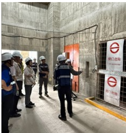
電梯井安全管制-運用AI智能技術 (1)_0_0_0
