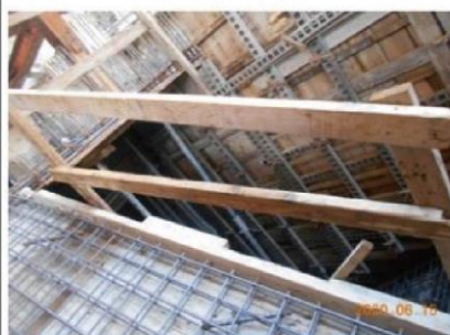
開口處搭設臨時護欄
