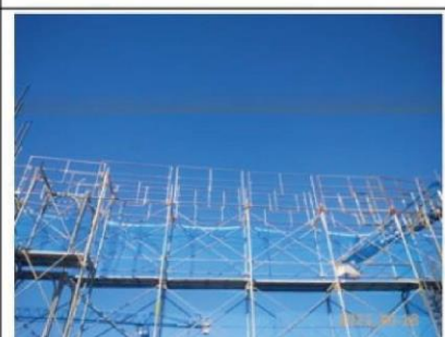
施工架安裝採扶手先行工法
