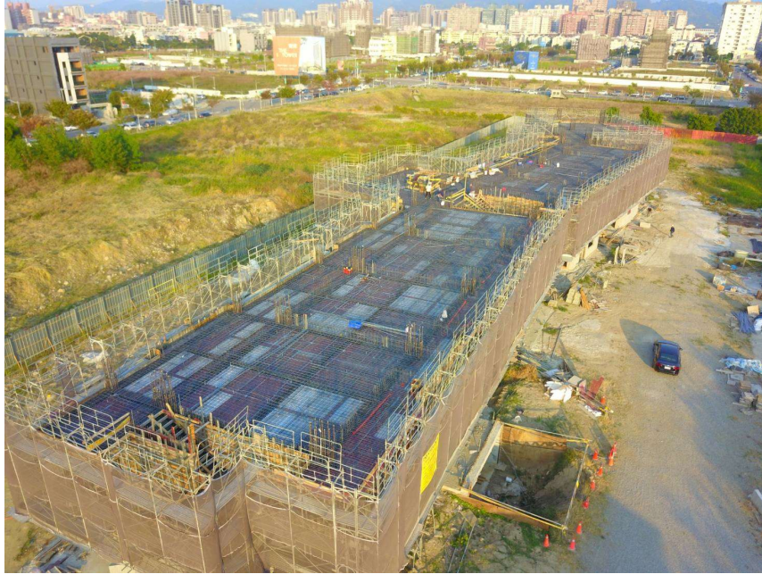
照片說明1:工區使用空拍機，清楚俯瞰工區概況。
