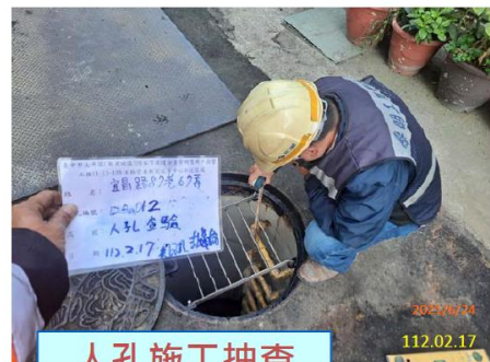
人孔施工抽查
