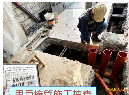
用戶接管施工抽查
